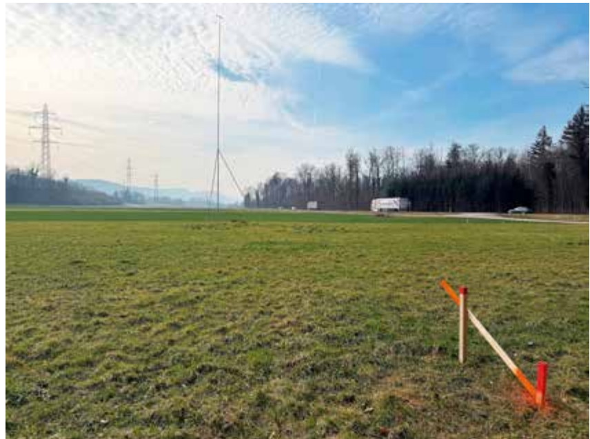
Die ausgesteckten Profile zeigen das Niveau der Auffüllung, welche dann eine neue Ebene bis auf die Höhe des Radweges Eiken – Kaisten bildet. Foto: Susanne Hörth
